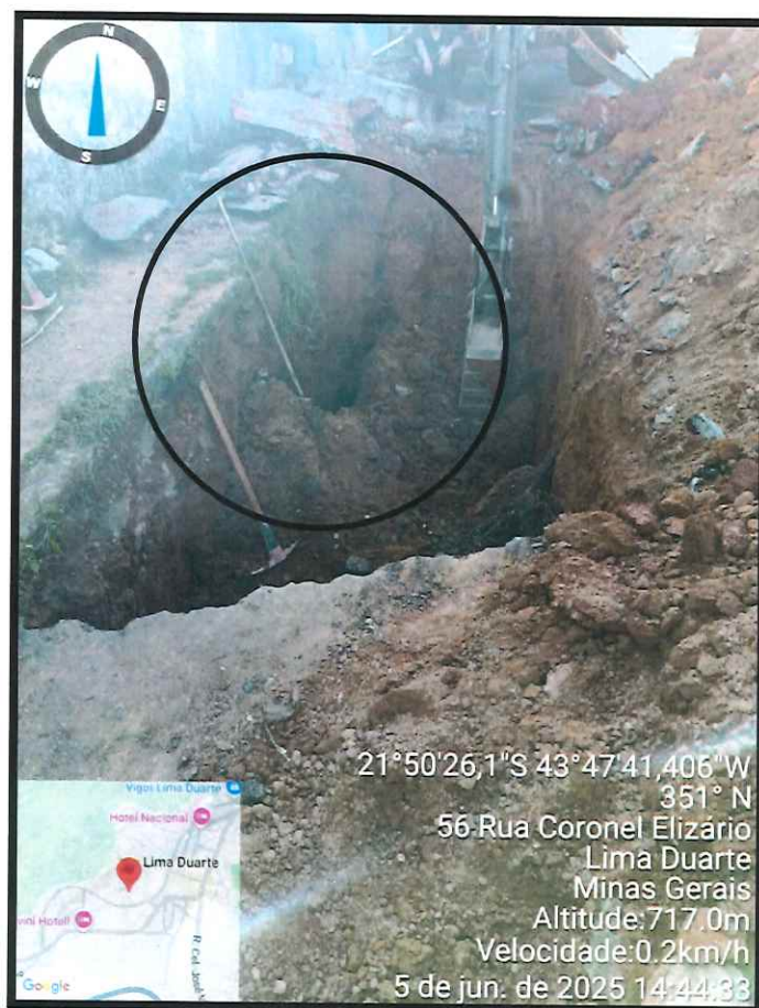
Imagem 06 - Afundamento de trecho do asfalto sugerindo comprometimento de manilha pluvial.
