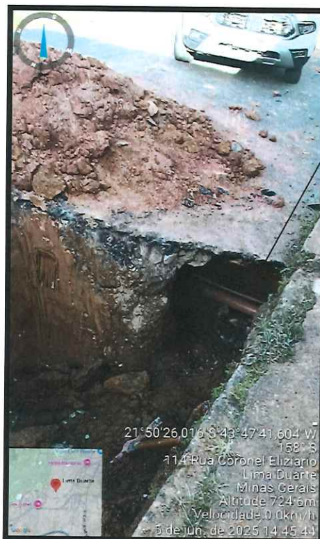
Imagem 02 - Exposição de solo erodido sob a via, evidenciando falha estrutural na base da rua.
