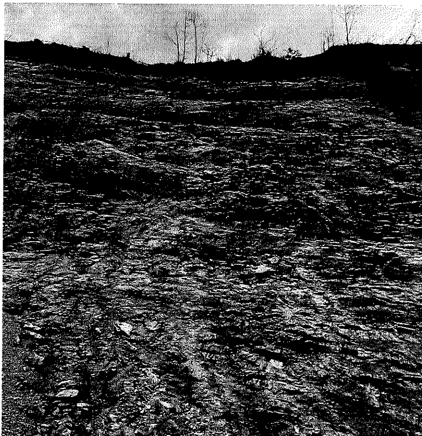
Foto 06: Porção medial do talude, com afloramento de maciço rochoso foliado.
