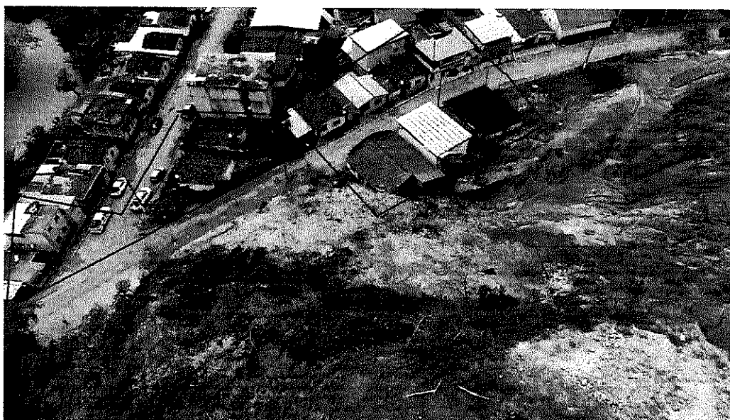
Foto 23: Área delimitada para remoção preventiva de moradores, em função do risco geotécnico identificado.
