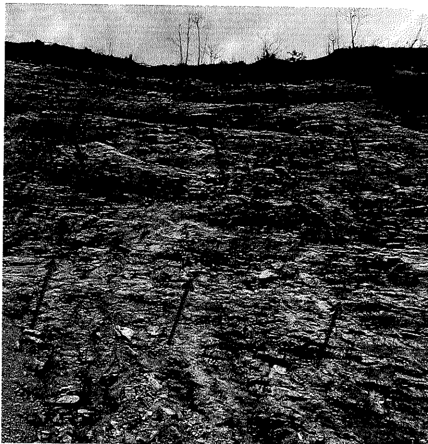
Foto 12: Maciço rochoso foliado com xistosidade e fraturas, em orientação desfavorável à estabilidade.
