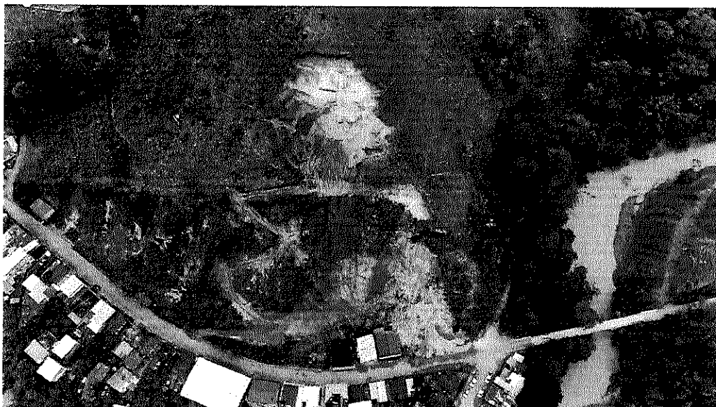
Foto 01: Vista aérea do talude e da área urbanizada a jusante.
