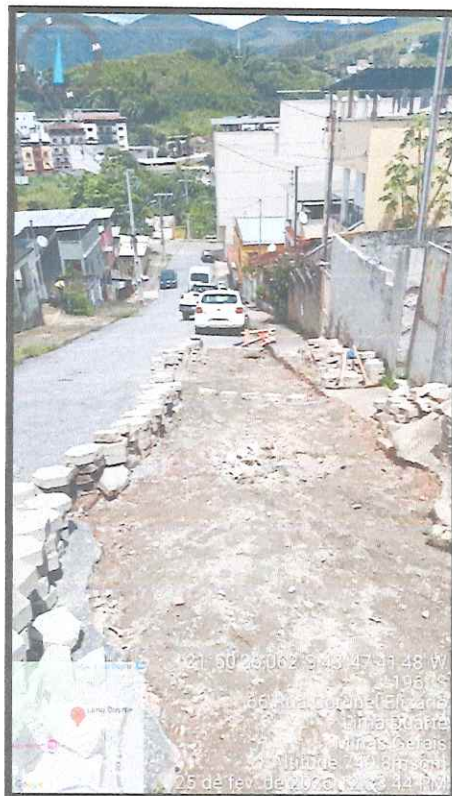
Imagem 11 - Trecho da via com pavimento removido e base exposta após intervenção emergencial para correção do solapamento causado pela drenagem pluvial.
