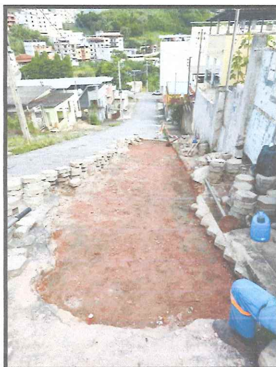
Imagem 14 - Trecho com base já regularizada e preparado para cobertura provisória com lona pela Prefeitura, visando proteção até a recomposição do pavimento.
