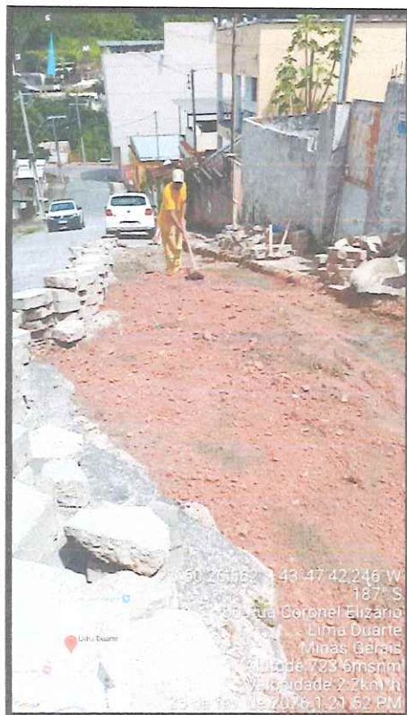
Imagem 13 - Regularização provisória da base com material granular após remoção do solo comprometido pelo processo de erosão subterrânea.
