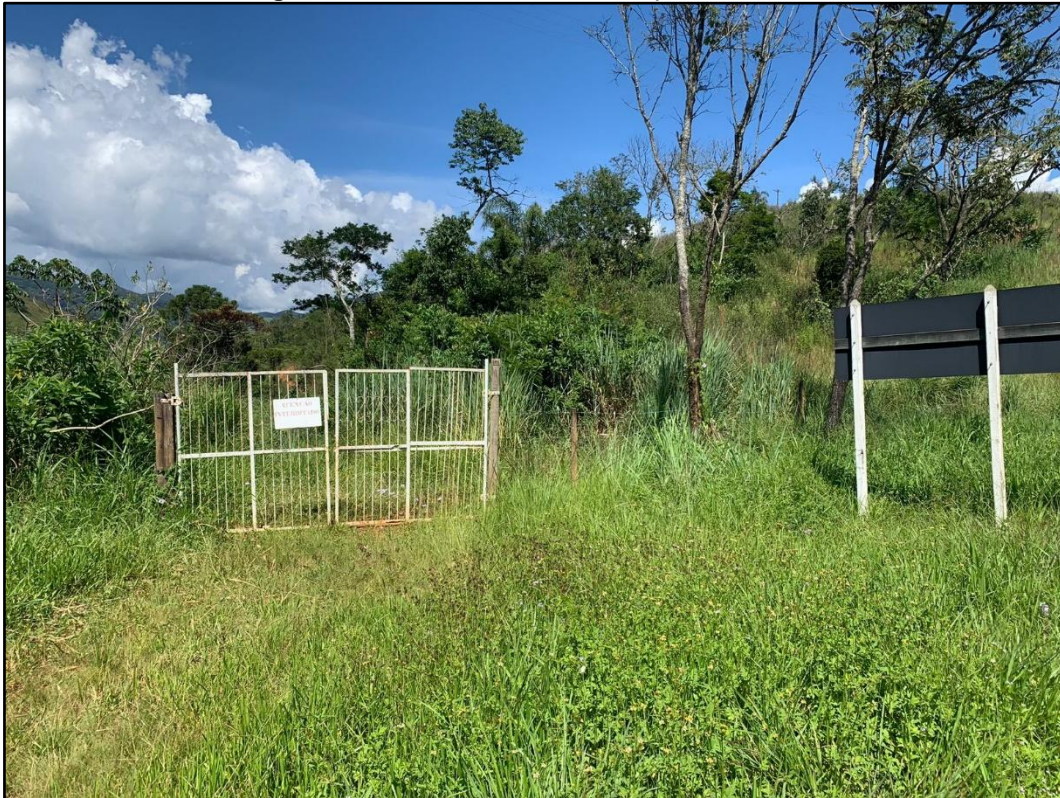
Figura 6: Portão de acesso ao empreendimento.
