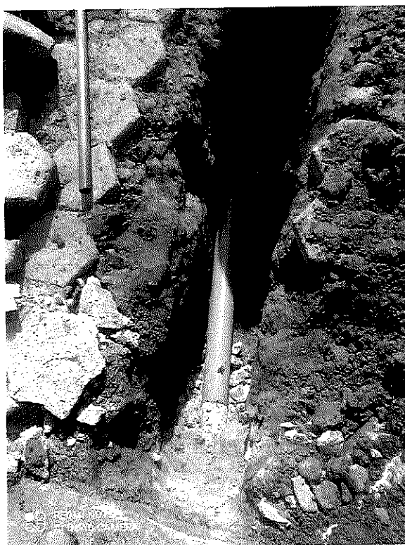
IMAGEM 01: Tubulação substituída e correção da inclinação.
