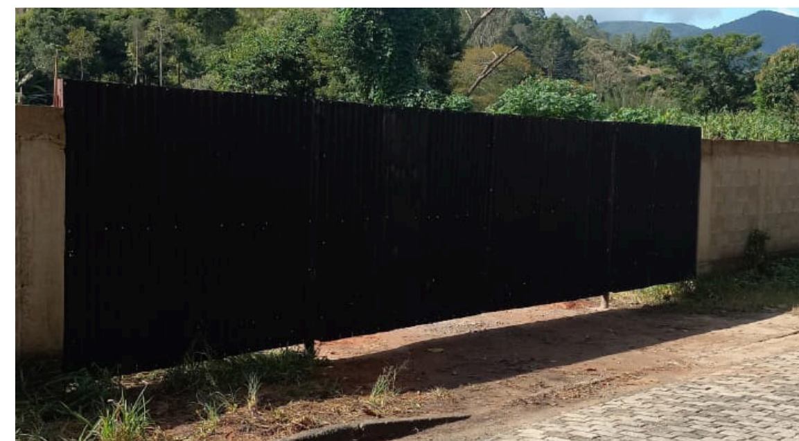
PORTÃO PARA FUTURA FÁBRICA DE BLOCOS
