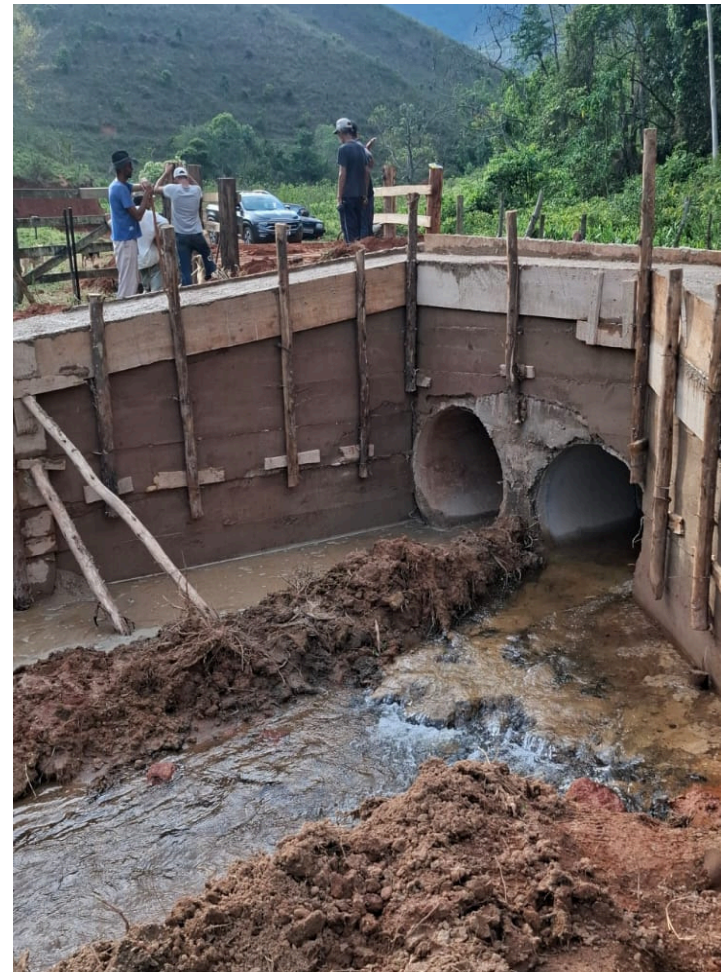
PONTE NA LOCALIDADE DE PINHEIRO
