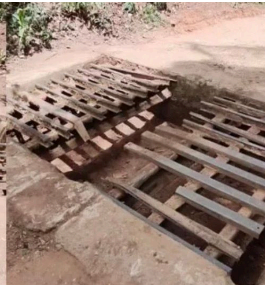
LIMPEZA, MANUTENÇÃO E SUBSTITUIÇÃO DE BARRAS DE FERRO DO MATA-BURRO, NA PONTE NOVA E CAETE
