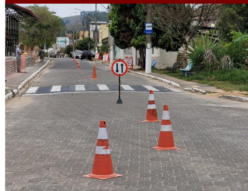
SINALIZAÇÃO - OBRA DE RESTAURAÇÃO DA PARADINHA
