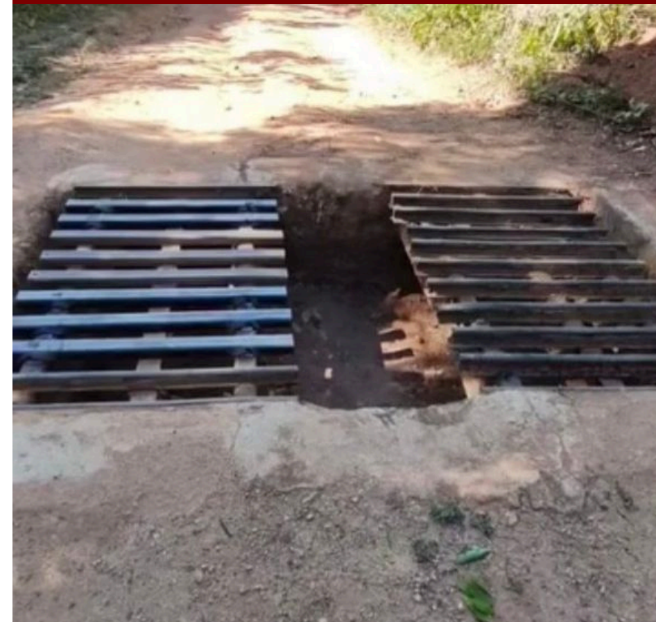
LIMPEZA, MANUTENÇÃO E SUBSTITUIÇÃO DE BARRAS DE FERRO DO MATA-BURRO, NA PONTE NOVA E CAETE
