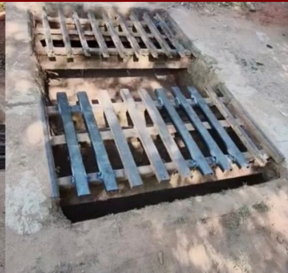
LIMPEZA, MANUTENÇÃO E SUBSTITUIÇÃO DE BARRAS DE FERRO DO MATA-BURRO, NA PONTE NOVA E CAETE
