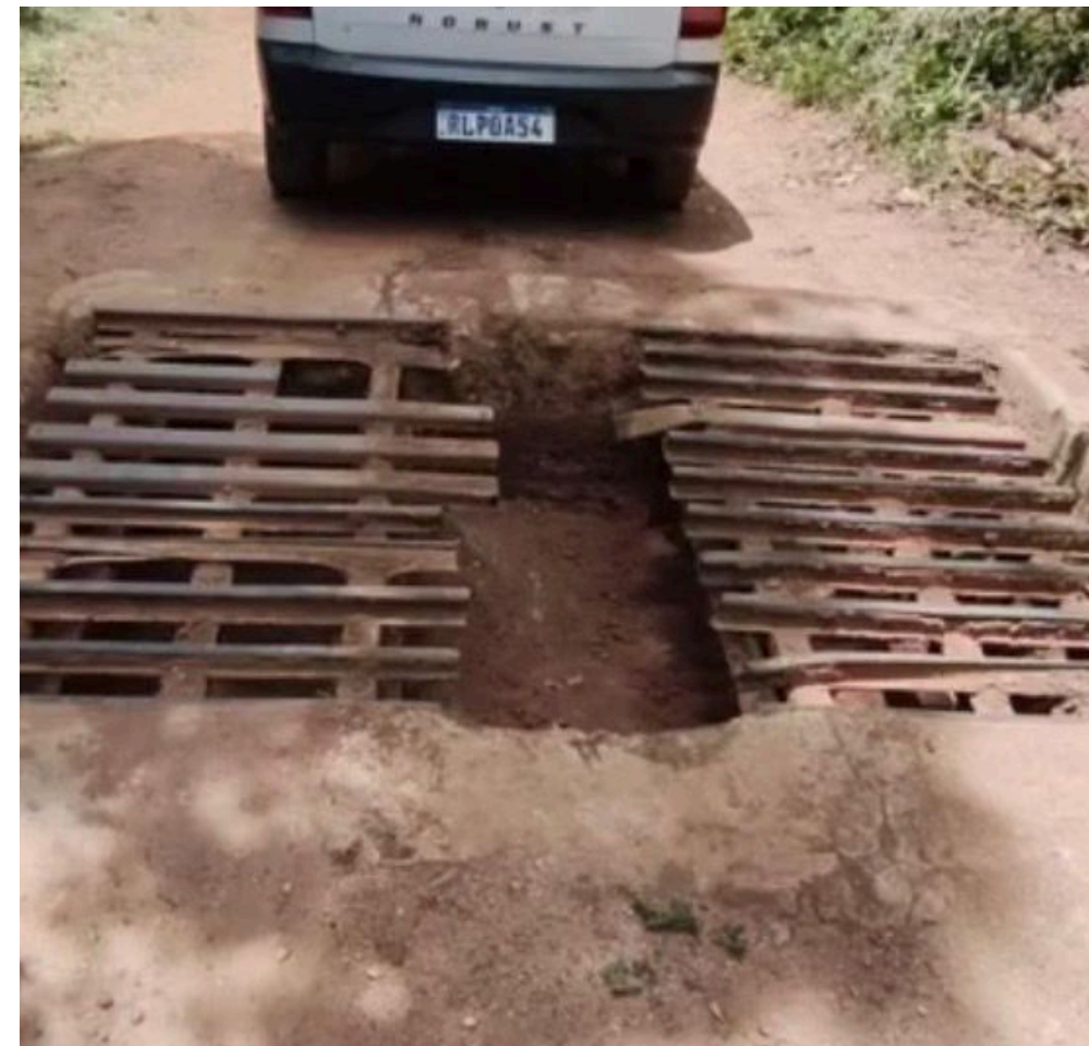
LIMPEZA, MANUTENÇÃO E SUBSTITUIÇÃO DE BARRAS DE FERRO DO MATA-BURRO, NA PONTE NOVA E CAETE
